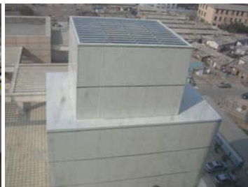
冷却塔隔声降噪工程
