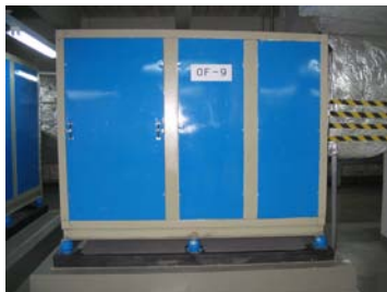
空调机组减振降噪工程
