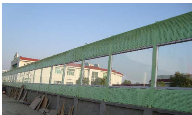
温厚高速南昌南隔声屏障工程
